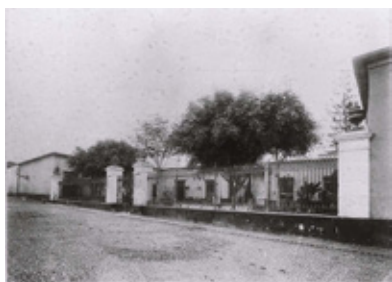
Hospital Civil de la Misericordia.
