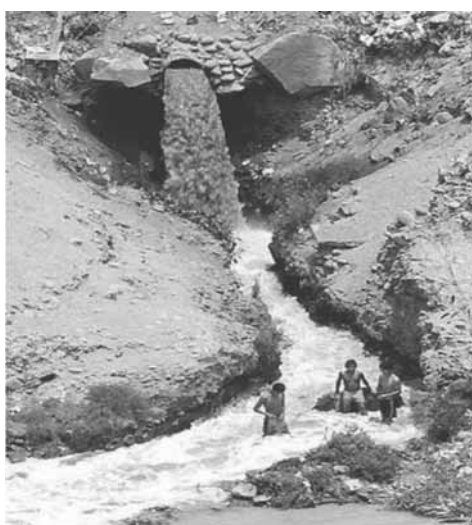
Fig. 3. El colector 6 ubicado a la altura de la cuadra 26 de la Avenida Perú, distrito de San Martín de Porres. Descarga su chorro de aguas servidas al río Rimac. Los niños se bañan aquí sin medir las consecuencias.
